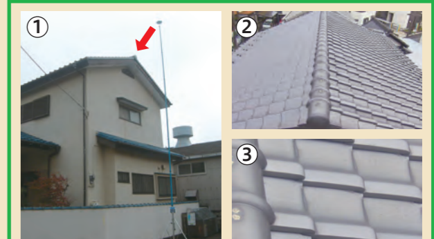
【参考】たかみ君による屋根点検撮影の手順
