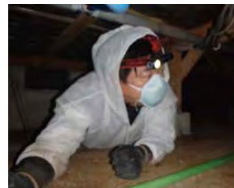
▲床下進入の様子
