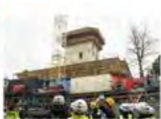
中大規模木造建設現場の視察
