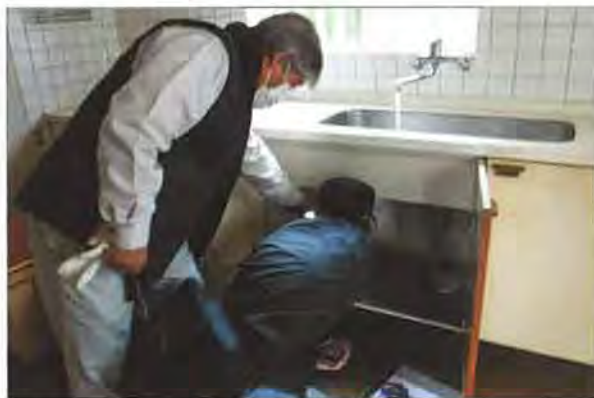
キッチン水栓を開いて排水をチェック中の菅雄治氏ら
