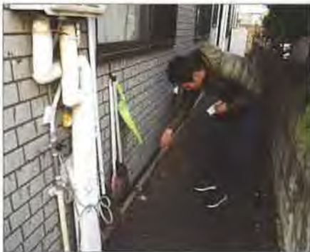
点検鏡を使って基礎にある染みの原因を調査中の参加者
