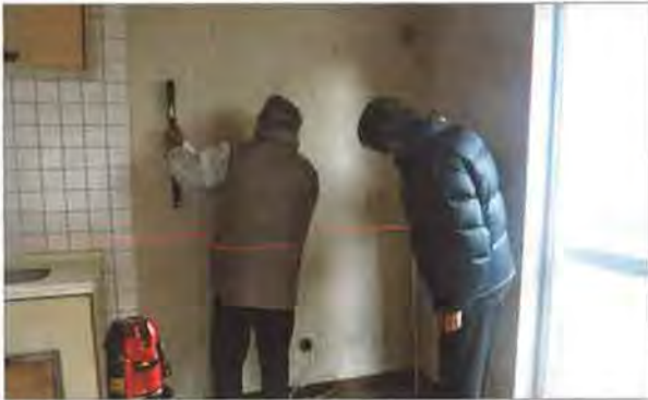
水平器で壁を計測中
