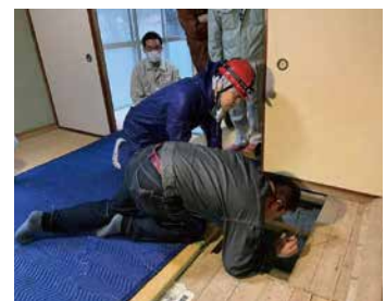
▲26日 床下侵入調査
